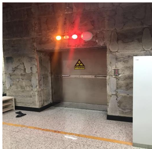
照片 3 加速器防护门及工作警示灯
